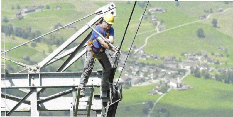
Ueli Schmitter fettet und dreht bei den Unterhaltsarbeiten die Tragseile seiner Brändlenbahn. (Foto: C. Perret)
